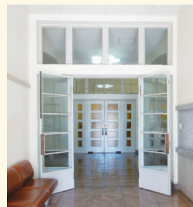
正面玄関のガラス扉
